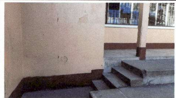
Foto 2: Pintura en muros exteriores
